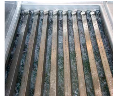
Riego con tubos rociadores ...
